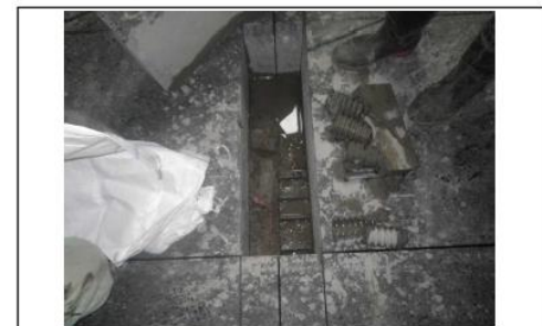
事故状況写真②
